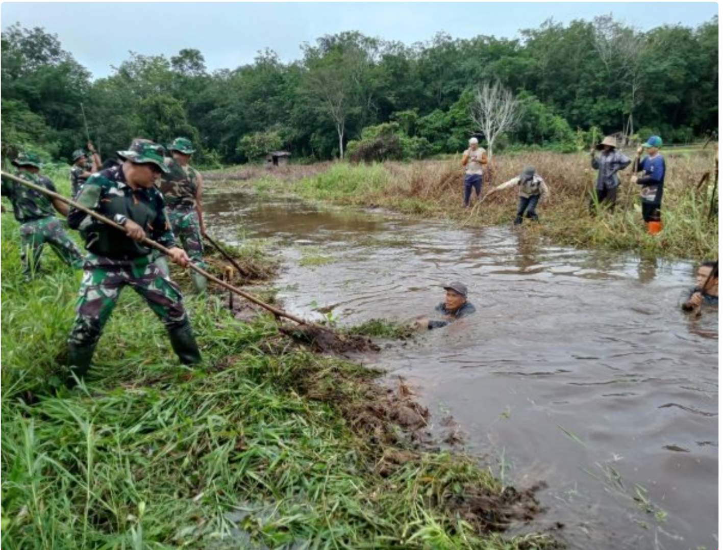
Cegah Batingsor Koramil 1001-05/Lampihong Bersihkan Saluran Air
